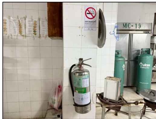
รูปภาพที่ 4.2.4 ถังดับเพลิงชนิดผงเคมี ชนิดน้ำยาเหลวระเหย และชนิดโฟม
