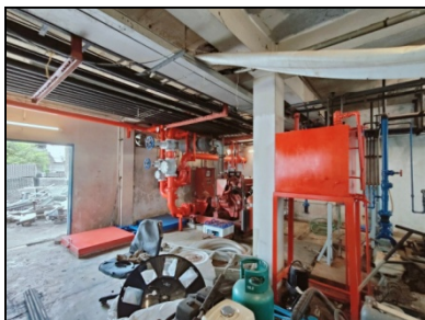
รูปภาพที่ 4.2.2 เครื่องสูบน้ำดับเพลิงและระบบส่งน้ำ
