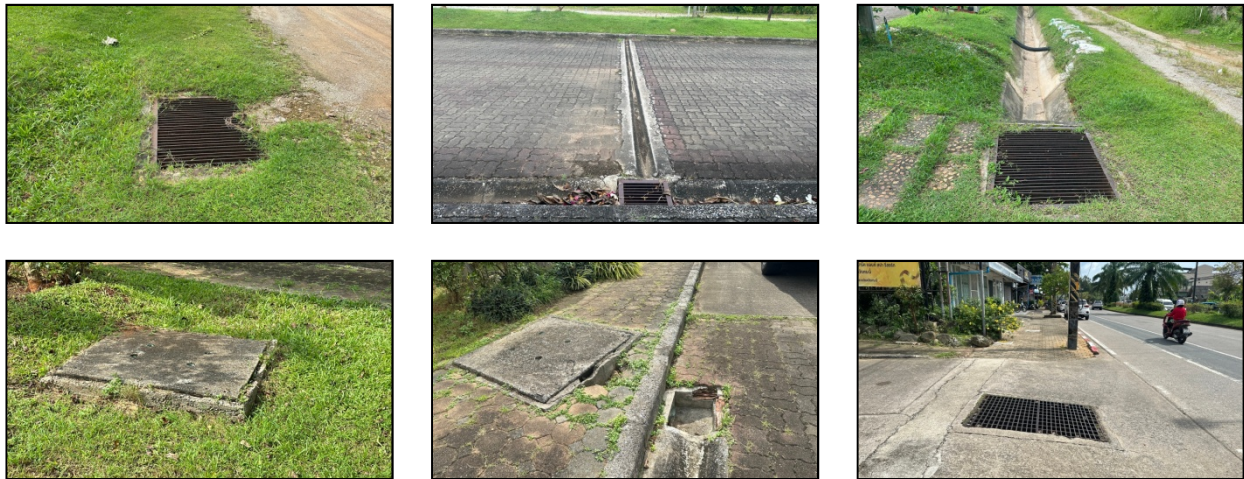
รูปภาพที่ 3.4.2 ตะแกรงดักขยะก่อนที่จะระบายน้ำฝนนอกบริเวณโรงแรม
