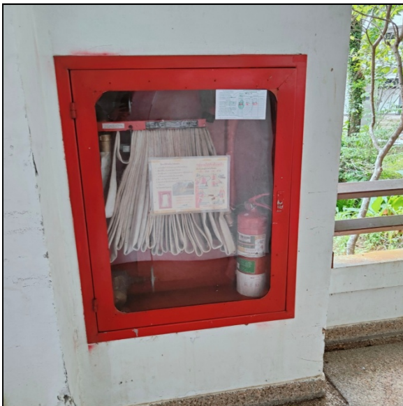
รูปภาพที่ 4.2.3 ชุดดับเพลิง (FHC)
