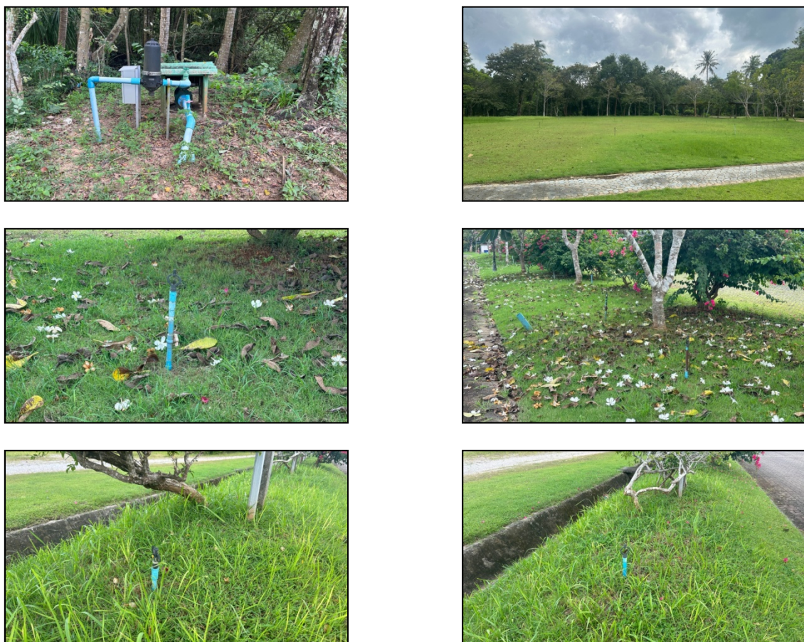
รูปภาพที่ 3.4.3 การนำน้ำเสียจากการบำบัดไปใช้ประโยชน์ รดน้ำต้นไม้
