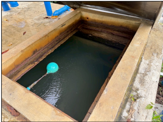
รูปภาพที่ 3.3.1 ถังเก็บน้ำใต้ดิน
